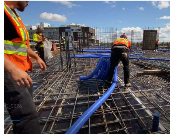
Figure 1 : Dérouler le conduit à la longueur requise en suivant le sens du conduit.
