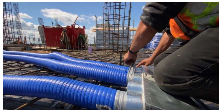
Figure 2: Ajouter une couche de ruban adhésif FLEXTAPE
