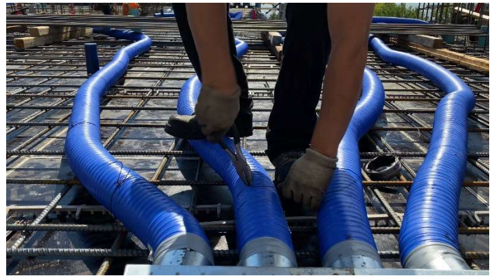
Figure 4 : Fixer solidement le conduit FLIXS à l'armature à intervalle régulier de 30 cm
