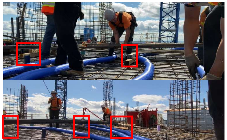
Figure 6 : Doubler les supports de bois lorsque des barres armatures sont déposées sur les réseaux de FLIXS
