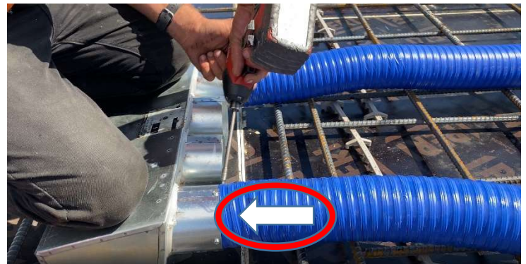
Figure 3 : utiliser des vis auto-foreuse pour fixer mécaniquement le conduit
